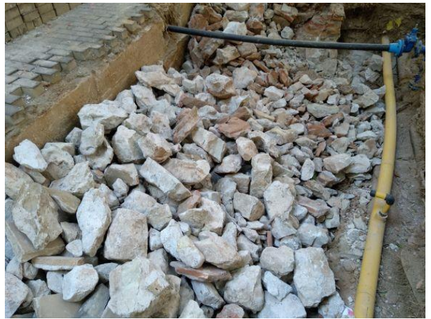
14. Estructures un cop desmuntades.
