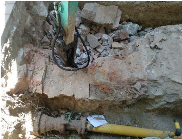
13. Desmuntatge de les estructures
