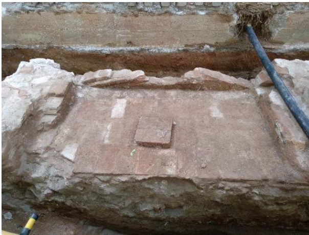
9. Vista del mur UE 115 i volta de maó del dipòsit UE 119.
