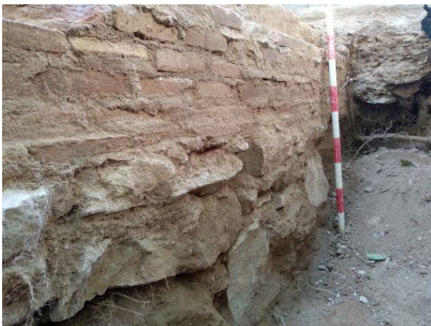
3. Fonamentació UE 141 i mur UE 115.
