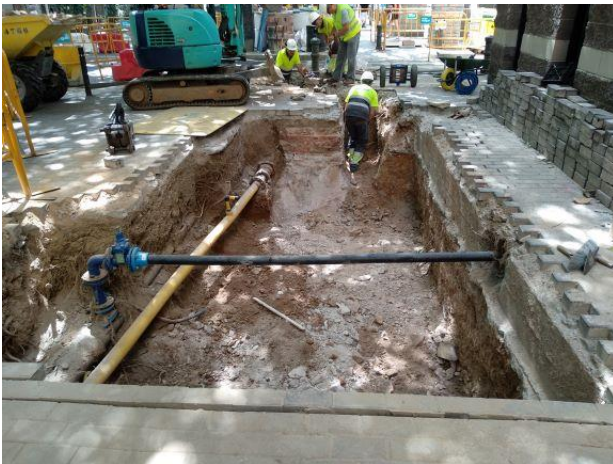
15. Finalització dels rebaixos
